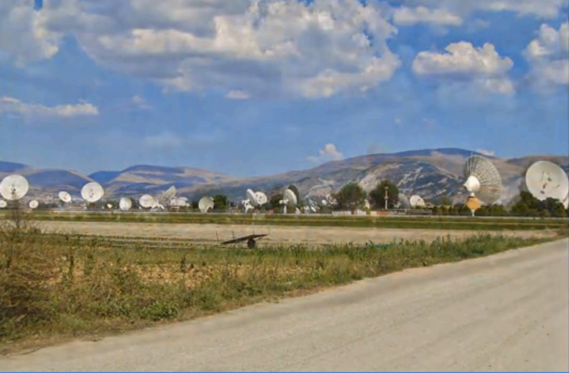
Piana del Fucino (Avezzano) – Antenne del centro spaziale Telespazio
