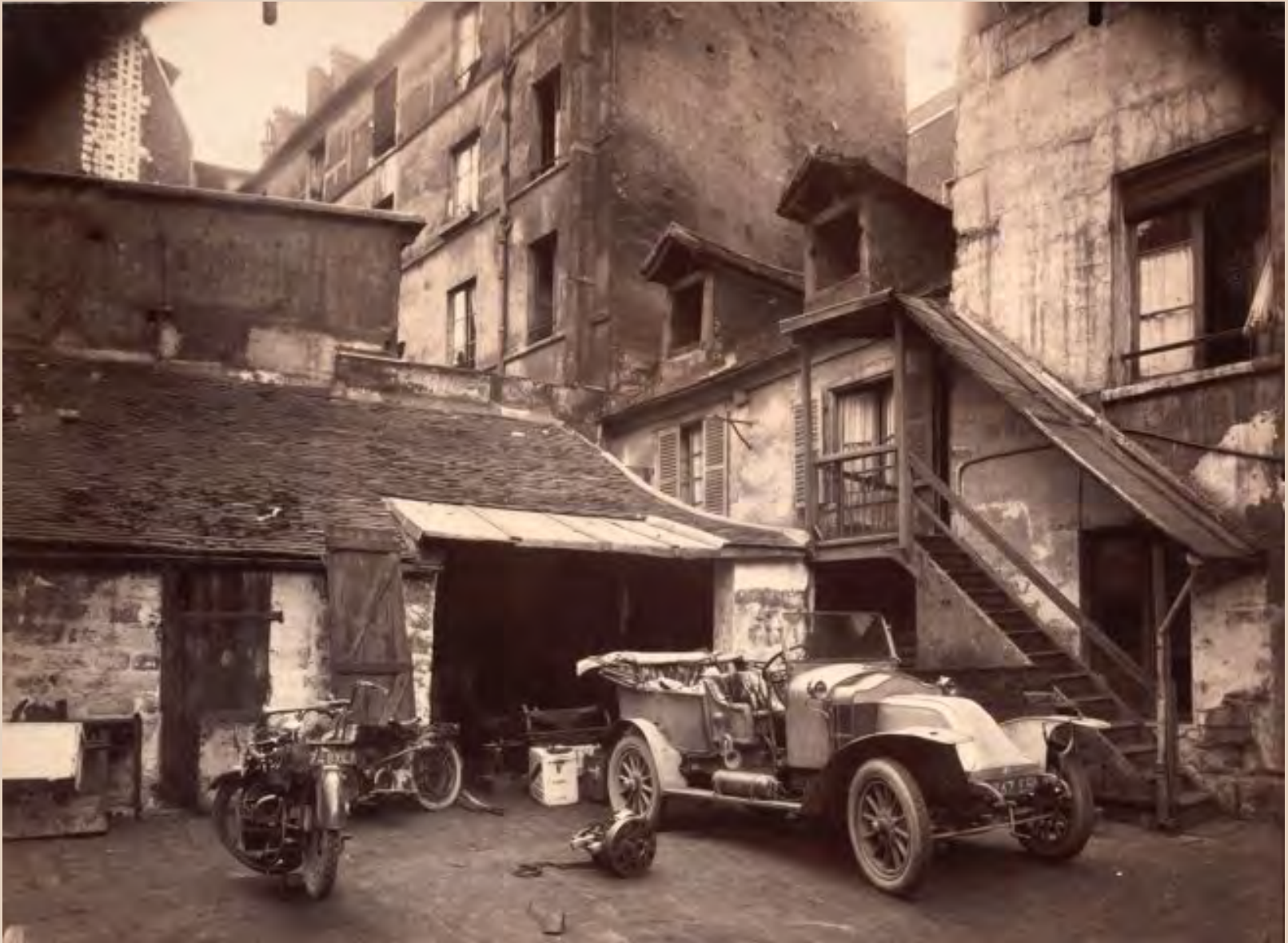
Cour, 7 rue de Valence, 1922
