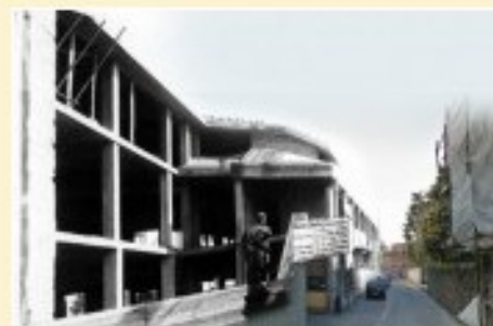
Ponte Vecchia E Nuova [12
