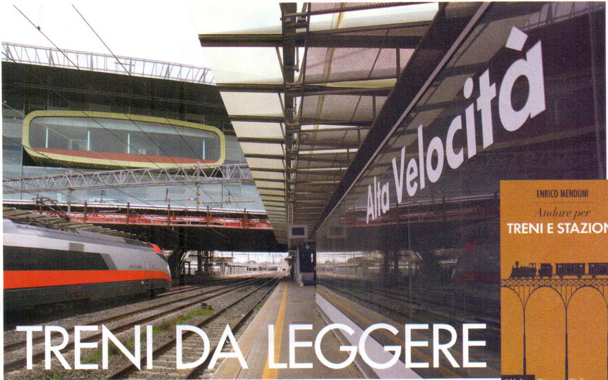
Uno scorcio della nuova stazione ponte di Roma Tiburtina © Vincenzo Tafuri/La Freccia
