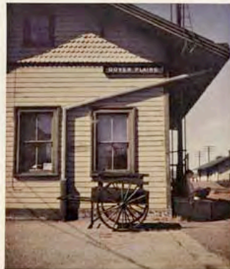
Dover Plains station, N.Y.C.R.R.
